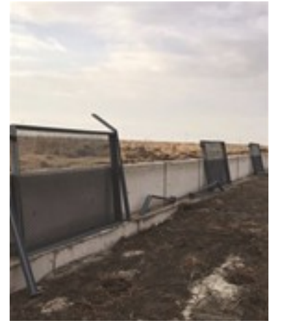
■ Fabrika ortamında hazır hale gelen panellerin hatlı duvar üzerine montajının yapılma işlemi.
