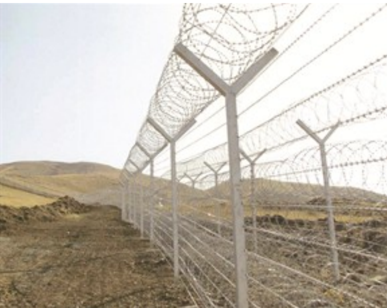
■ Detay ve projeye göre hazırlanmış yüksek güvenlik amaçlı jiletli ithal imalatlarının montaj görüntüleri.
