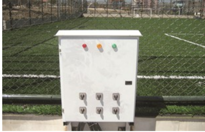
■ Kumanda panosuna yerleştirilen pako şalterler sayesinde, her direk ayrı ayrı kontrol edilebilmektedir.
