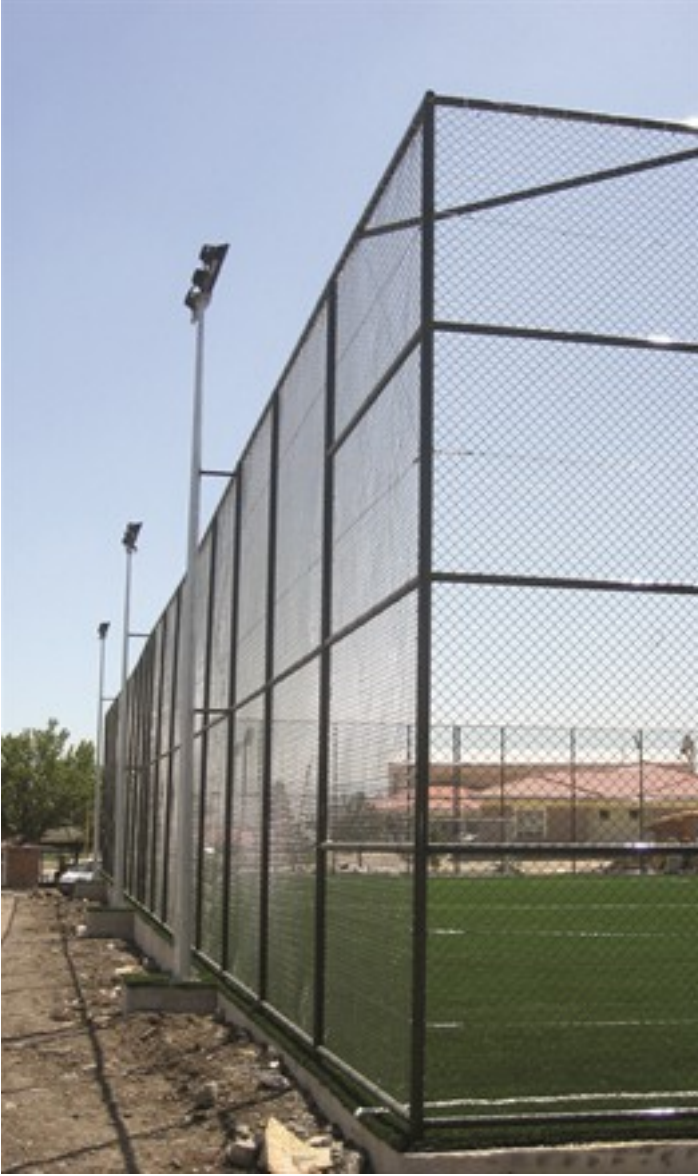
■ Aydınlatma direkleri, zemine beton ile sabitlenen ankaraj malzemelerine montaj edilir. Ankaraj malzemesi gömülürken, aydınlatma kablolarının geçeceği plastik borular beton içerisinde yerleştirilir.
