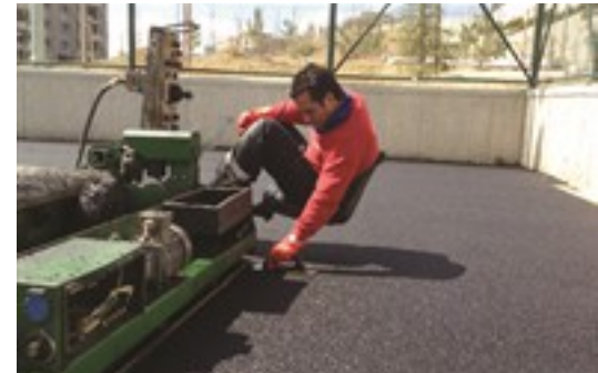
■ Primer uygulaması kūr aldıktan sonra İthal Poliüretan Prepolimer (Binder) ile bağlanmış 1-3 ya da 1 – 4 mm çapında SBR granül malzeme, özel makinalar (finisher) yardımı ile sahaya serilecektir.
