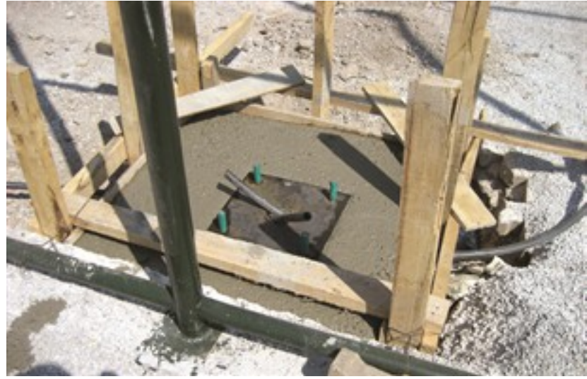
■ Aydınlatma direkleri, zemine beton ile sabitlenen ankaraj malzemelerine montaj edilir. Ankaraj malzemesi gömülürken, aydınlatma kablolarının geçeceği plastik borular beton içerisinde yerleştirilir.
